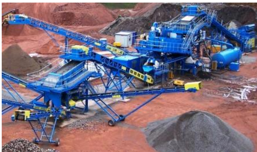
Figura: Concasor materiale de constructii
